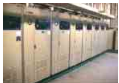
小型ボイラー
