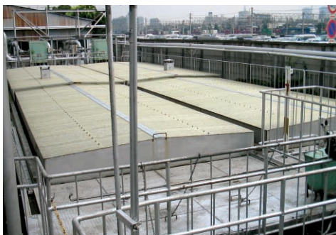
排水処理槽カバー
