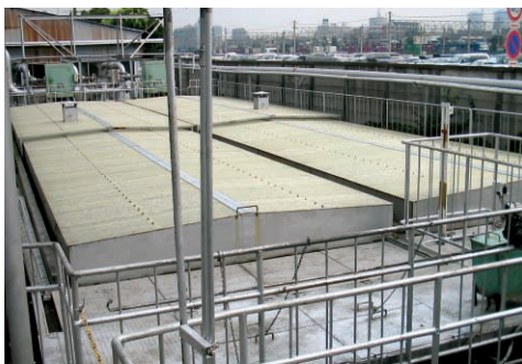
排水処理槽カバー
