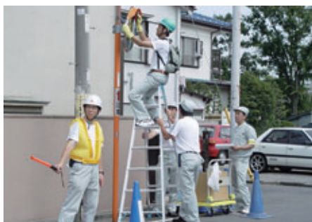
カーブミラー清掃作業
