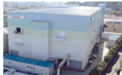
川崎の新塗装工場
