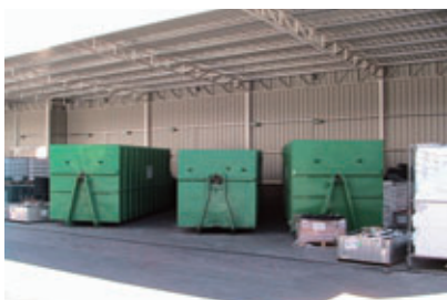
廃棄物回収場の分離と屋根の設置
