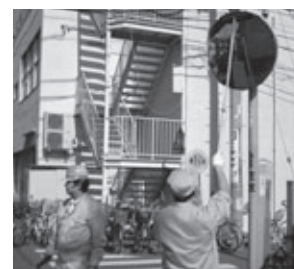
カーブミラーの清掃の様子
