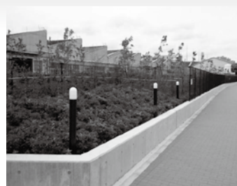
コンクリート塀のネットフェンス化
